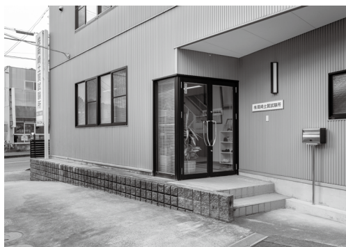
岡崎土質試験所の外観 （画像提供：株式会社岡崎土質試験所、以下同じ）
