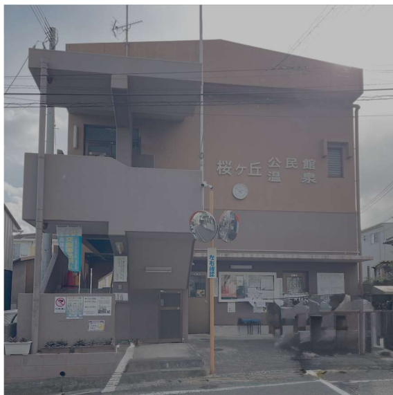
桜ヶ丘温泉の外観
