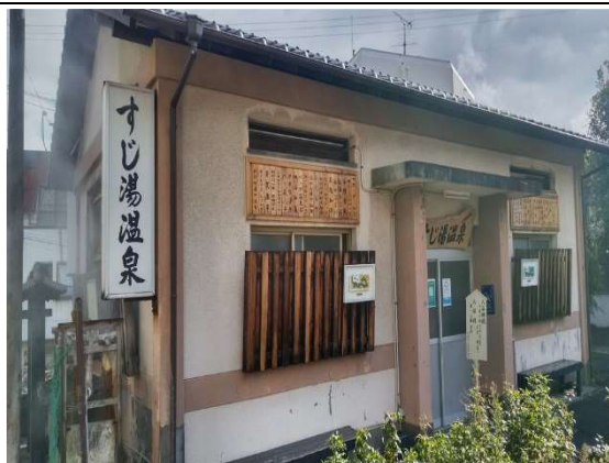
鉄輪すじ湯温泉外観
