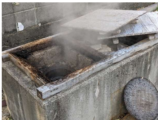
地獄蒸しの設備
