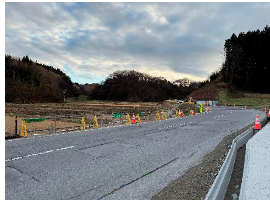
◇施工現場の様子
