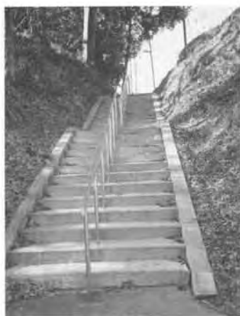
「上池公園」から「総社宮さま」へ続く坂道。いつのまにか階段になっていた
