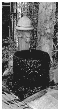
役立ったものとして左の写真にあるような水栓柱がある。大火以前から設置されていたようであるが、その当時のものは、大火の際に壊れたりしてなくなってしまったので、復興に際して、改めて作成したものであるとか。現在設置されているものの本体は、鉄鑄物で、竜の頭をした部分から水が止まることなく流れている。非常に可愛い物である。これが、温泉街中心部のほとんどの家の前に設置されている。
