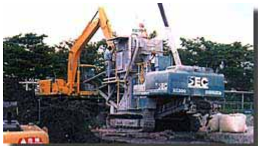
改良土まき出し
