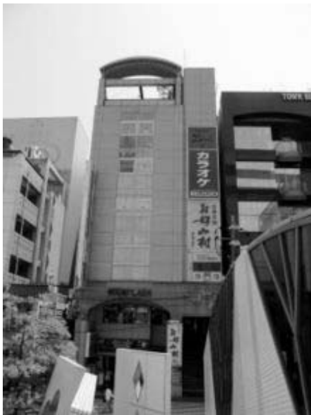
お好み村（第二代 ビルに建て替え）
