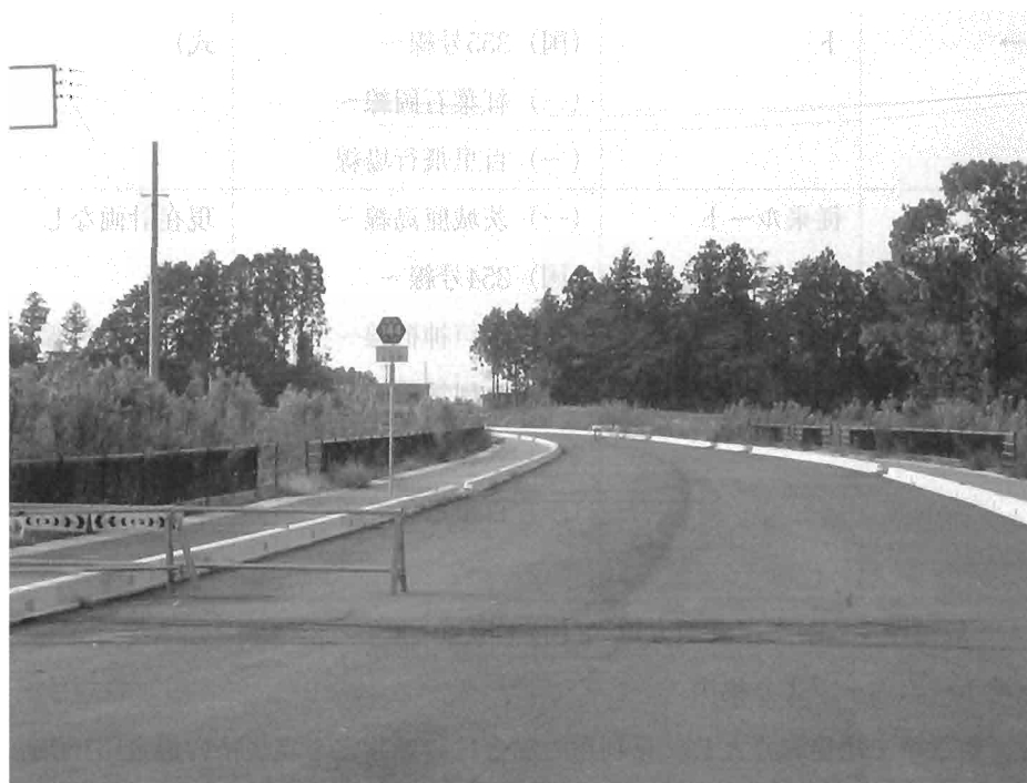
〔2〕 一般道路 紅葉石岡線（空港方面）
