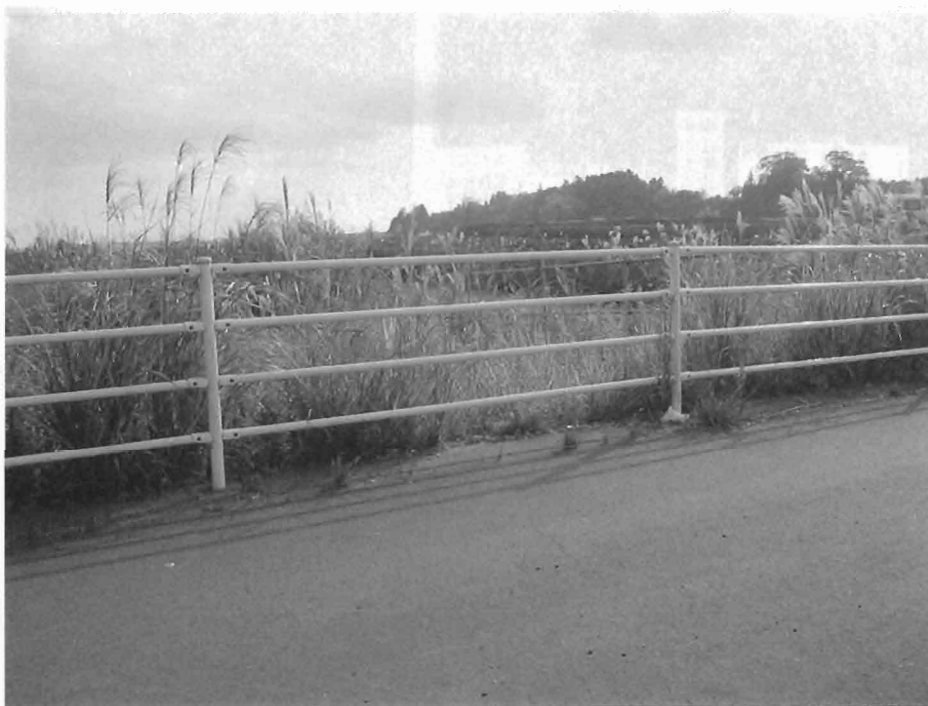
〔8〕 国道6号千代田石岡バイパス（恋瀬橋付近）
