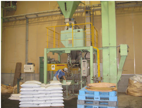
【図表 5-2-8 機械設備】
