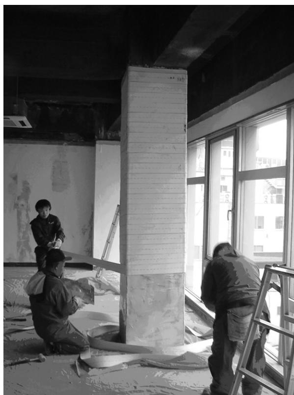
写真3. SRF工事中。接着剤を塗布してポリエステル繊維を柱に巻きつけて補強する。
