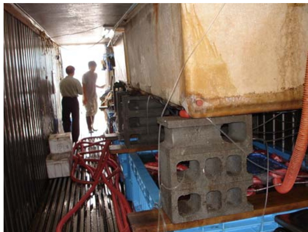
ユニットハウス内（※右側の上下が水槽）
