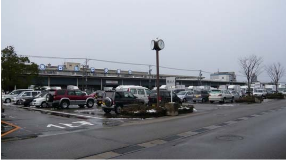
写真 2-1 金沢市中央卸売市場水産物部の取扱高もピーク時の約 1,000 億円から半減してしまった
