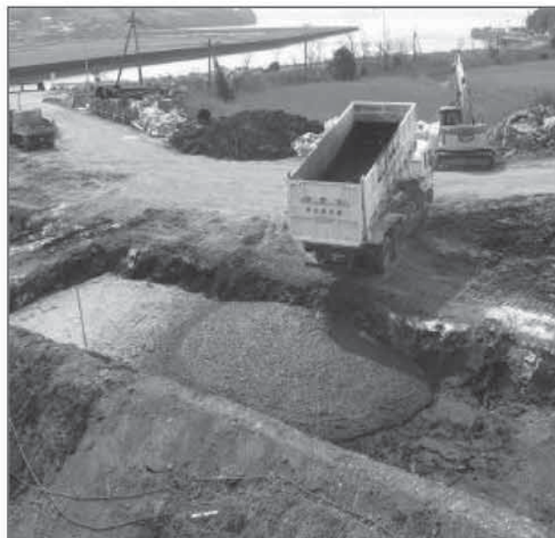
水密性ダンプトラックで仮置き場へ運搬
