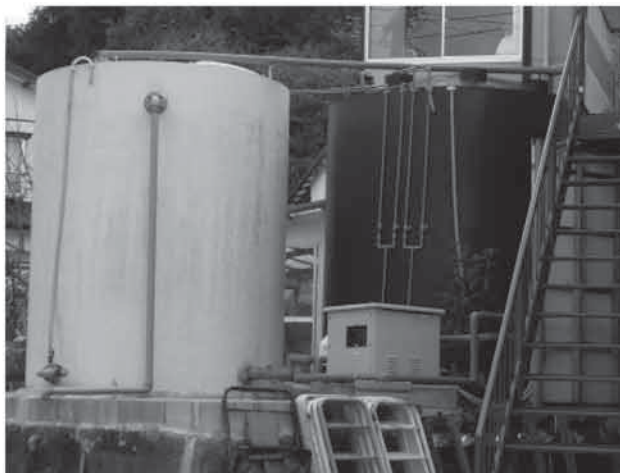
工場用水タンク
