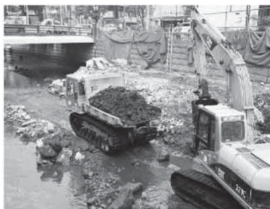
攪拌 30 分後積み込み運搬処理
