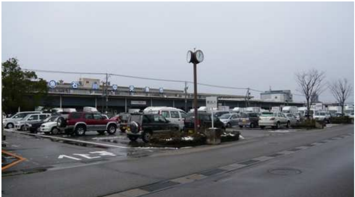
写真 3-1 金沢市中央卸売市場（管理事務所側より水産物部方向を望む）
