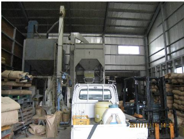
遠赤外線乾燥機、放冷タンク、粃摺り機、色彩選別機等の機械類（その２）
